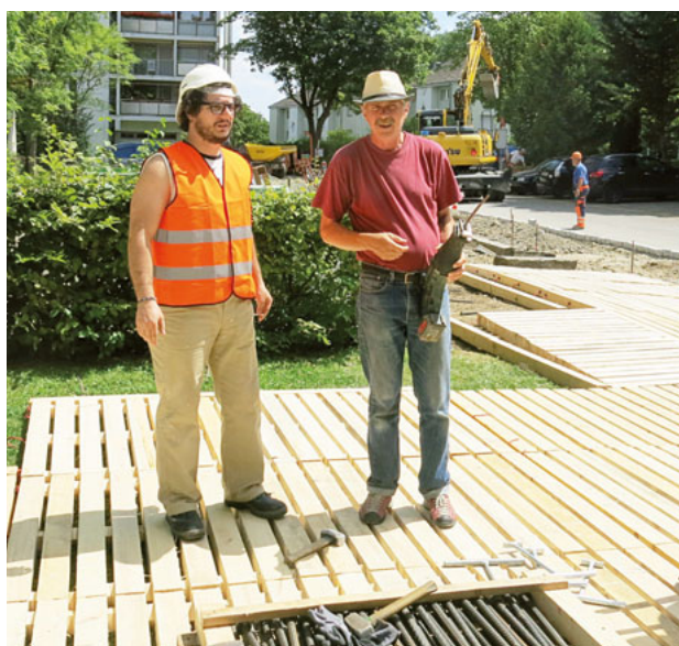
Rechts neben einem Mitarbeiter der Stiftung Chance steht Markus Wohler, Geschäftsführer von Passareco AG, und gibt Anweisungen. Jeder Holzrost ist vorgespannt; die Bodenroste werden dicht aneinander verlegt.
