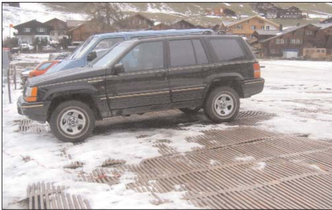
Winterparkplatz in Adelboden - ecopark trotz den enormen Belastungen
