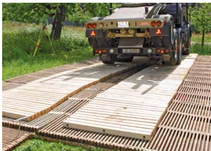
La flexibilité des éléments répartit la charge
