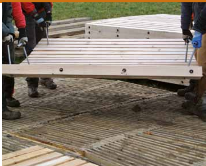
ecotruck est installé en un tour de main
