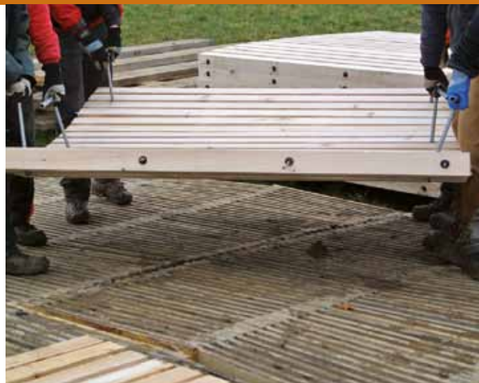
ecotruck lässt sich von Hand verlegen
